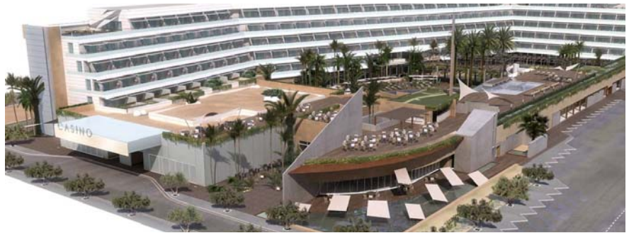
► Proyecto del Ibiza Gran Hotel, del Casino de Ibiza, actualmente en construcción
